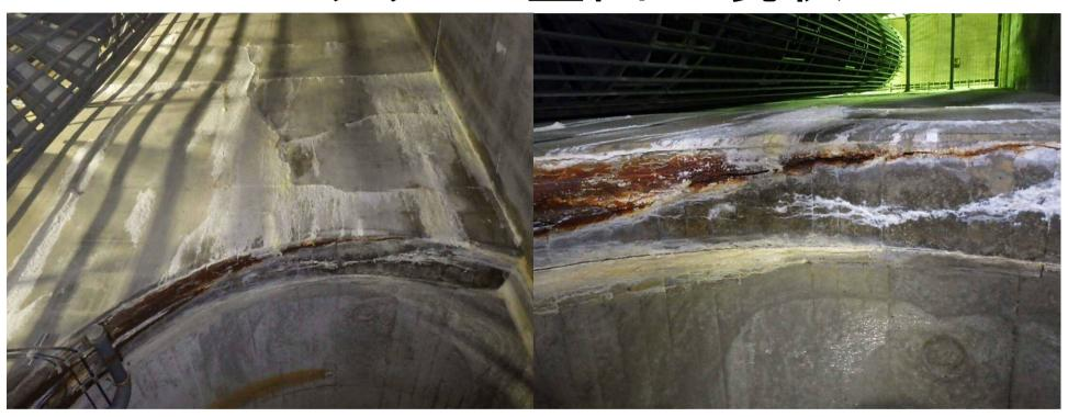
立坑壁厚45cm 鉄筋かぶり10cm 鉄筋腐食膨張によるコンクリートの浮き
