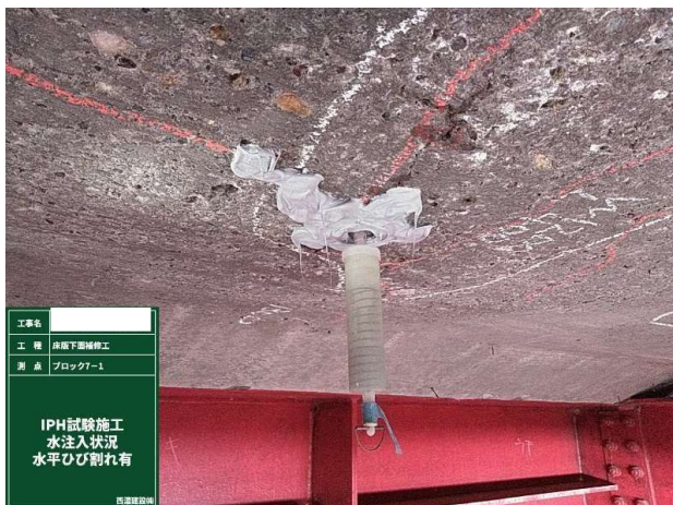
下面調査浮き箇所 試験施工時 水注入 バネ押切
