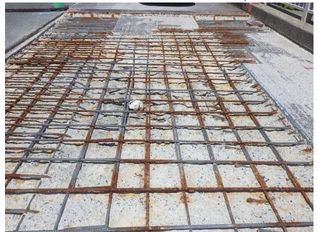
上面補修時損傷大
