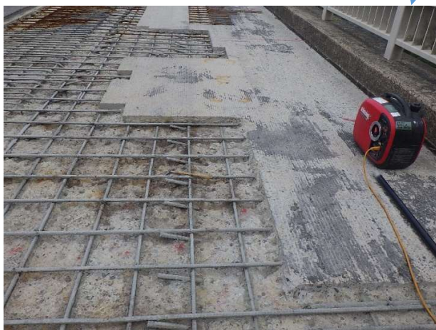
上面補修時損傷大
