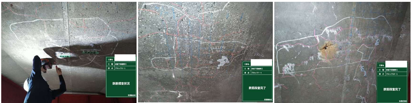
電磁波レーダーによる鉄筋探査
