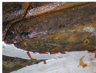
注入する事により、内部の錆汁を押し出す。
