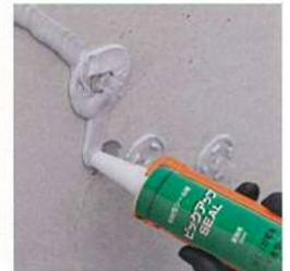
台座取付け部分以外のひび割れにシールします。
