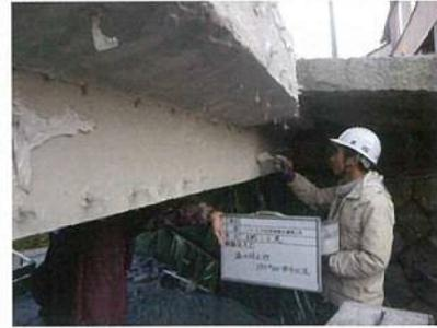
注入口以外のひび割れには、樹脂漏れを防ぐ為、ピックアップシール又はIPH#300により密封します。
