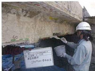
欠損部は鉄筋防錆ペーストIPH#300を塗布後、断面修復材IPH#600で補修し注入ポイントをマーキングします。
