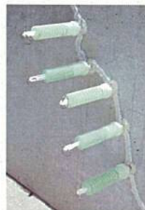
（漏水部の注入状況）
